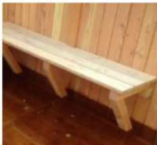
Banc de 50 cm de large, immergé 50 cm environ sous la margelle
